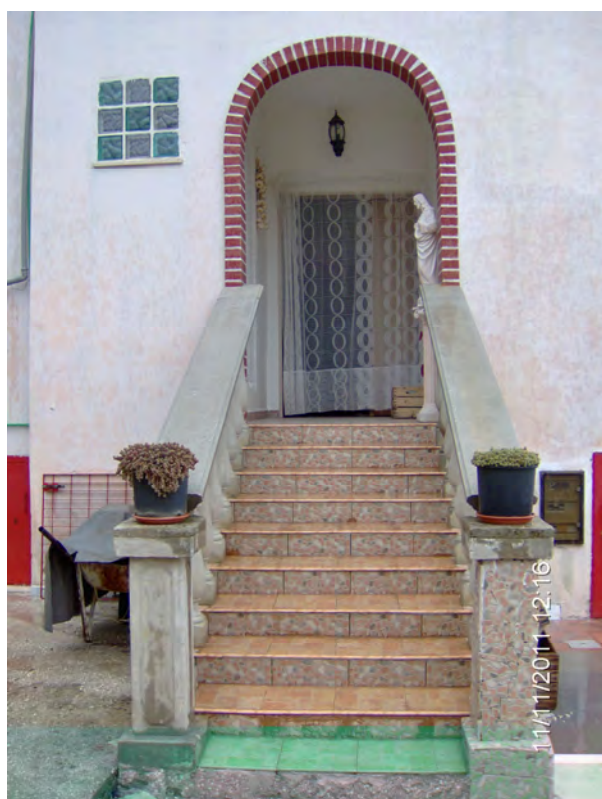
02 - Scala di accesso
